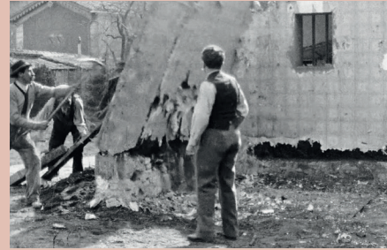
Démolition d'un mur Cinématographe Lumière France 1896
